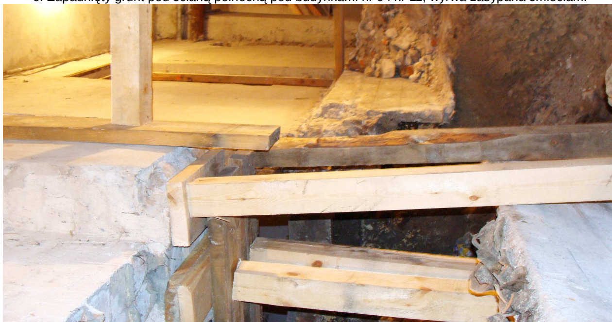
7. Urwane fundamenty pod ścianą podłużną i rogiem ściany zachodniej, prowizorycznie podstemplowane
