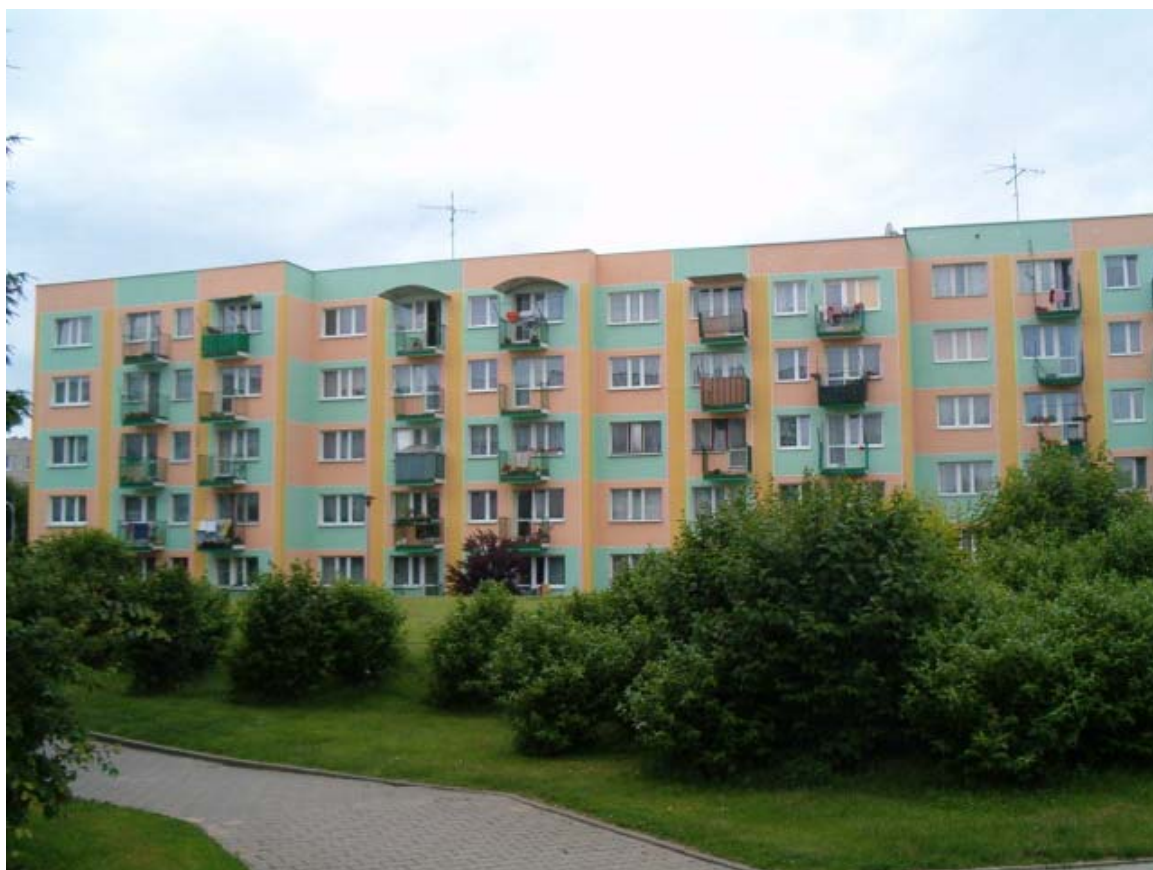
Fot. Nr 2 Inwentaryzacja fotograficzna – Elewacja Wschodnia.
