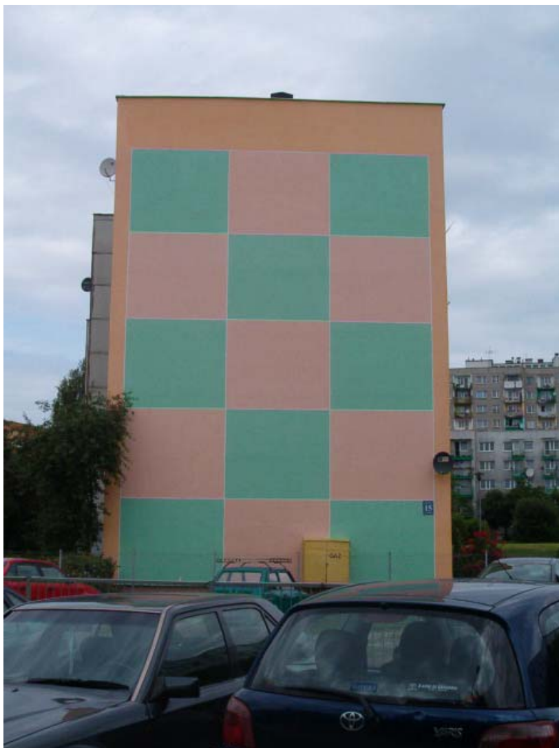
Fot. Nr 1 Inwentaryzacja fotograficzna – Elewacja Południowa.
