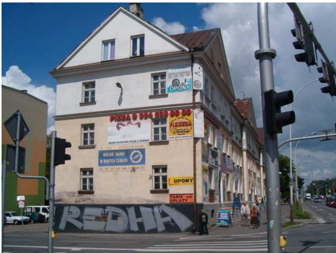
Fot. nr 2 – Elewacja południowa
