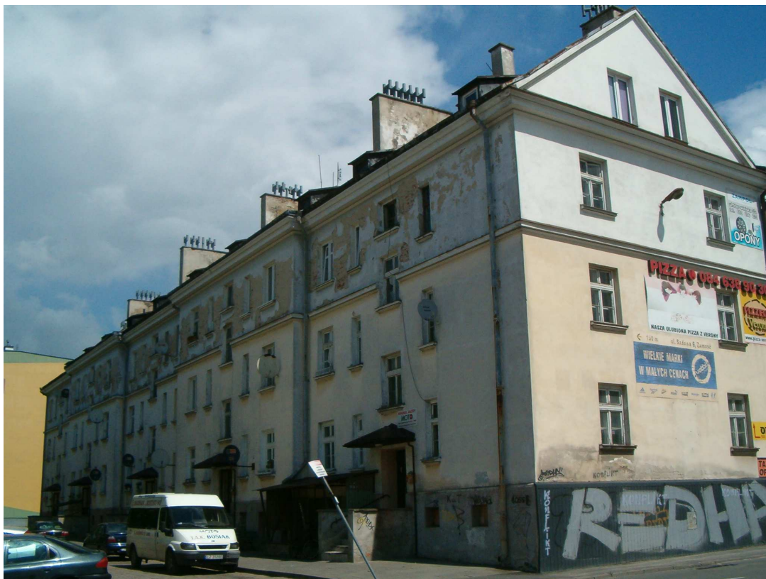
Fot. nr 3 – Elewacja wschodnia
